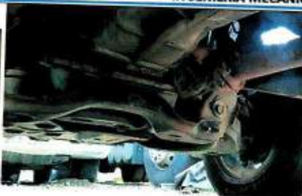
FUGA DE ACEITE DE MOTOR
